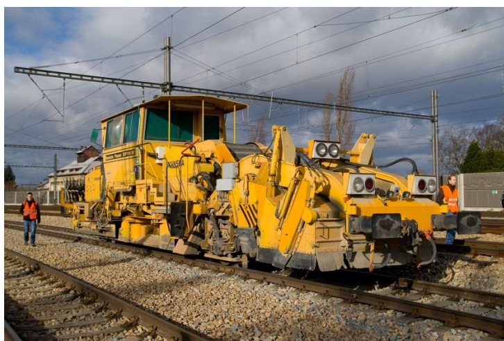
Obr. 2. Prohlídka strojů užívaných při modernizaci a opravách železničních tratí
