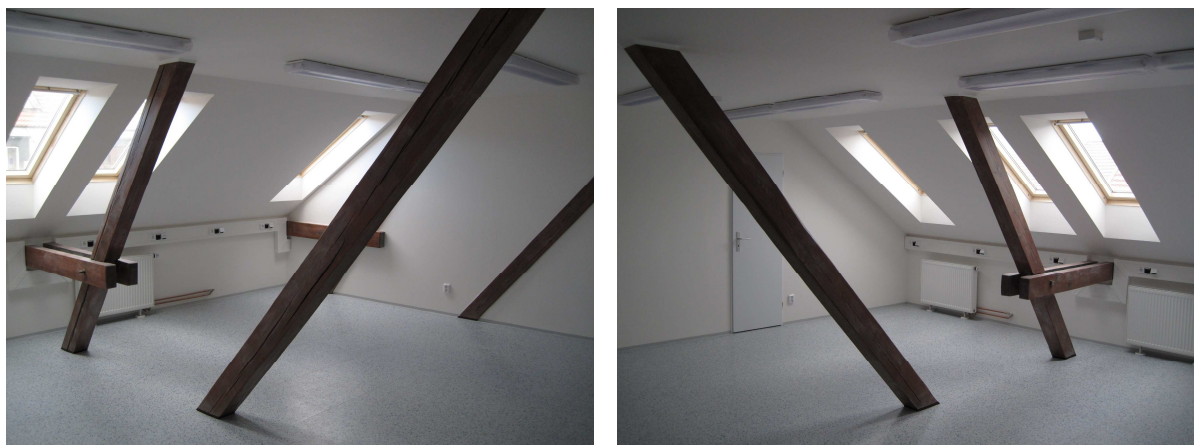
Obr.: zrekonstruované místnosti půdních prostor
