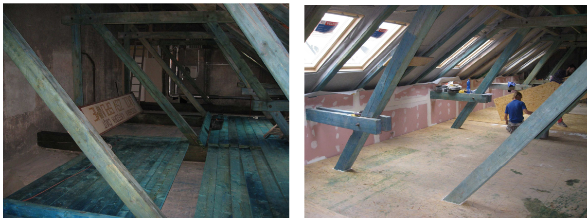
Obr.: probíhající rekonstrukce půdních prostor
