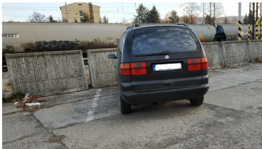
Obr. 22 - Betónová stena medzi parkoviskom a železničnou traťou
