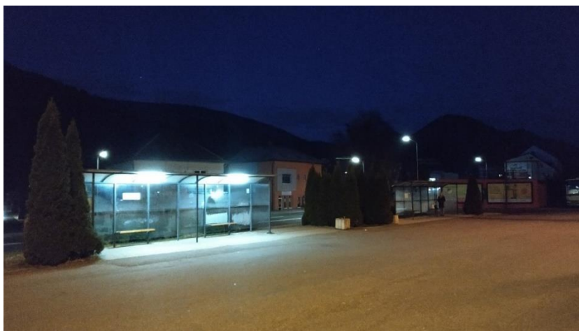
Obr. 35 - V popredí osvetlené nástupište 2 PAD, v pozadí neosvetlené nástupište 3
