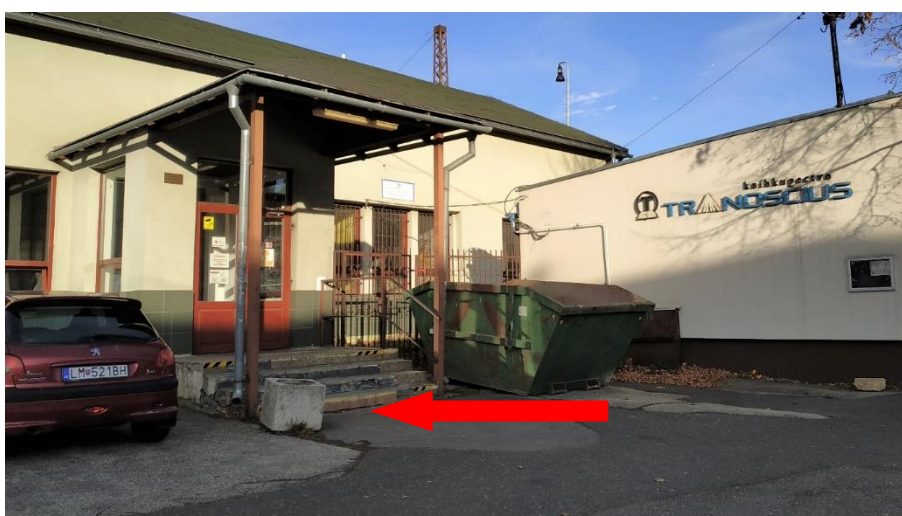
Obr. 29 - Nevhodne umiestnený odpadkový kôš pred vstupom do vestibulu
