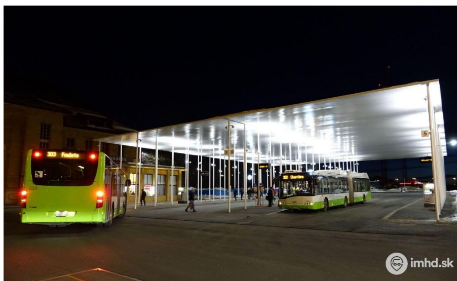
Obr. 51 - Jednoduché zastrešenie prestupného uzla v meste Le Chaux-de-Fonds zdroj: (46)
