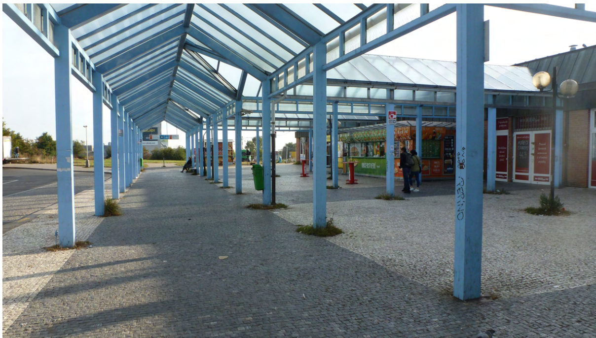
Obrázek 25: Pohled na současné odjezdové stanoviště číslo 5 (nově 10). V rámci přestavby je počítáno se zachováním stávajícího zastřešení v rekonstruované podobě.
