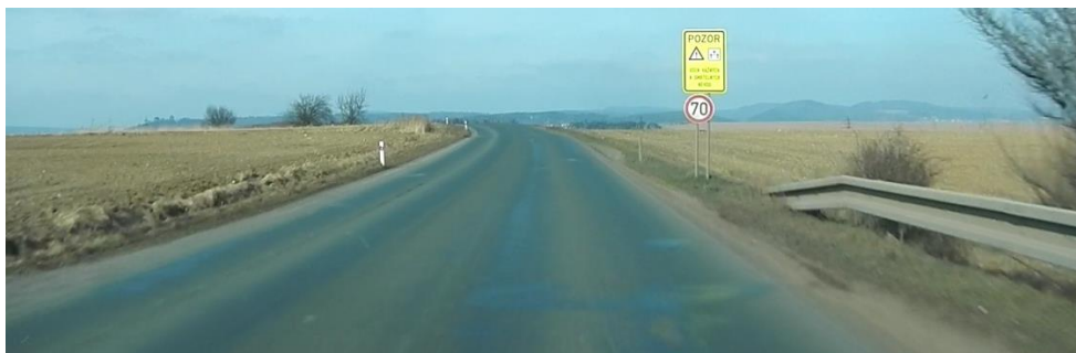
Obrázek 10: Pohled na začátek rekonstruovaného úseku proti směru staničení
