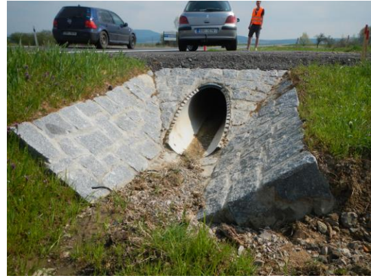
Obrázek 29: Čelo propustku
