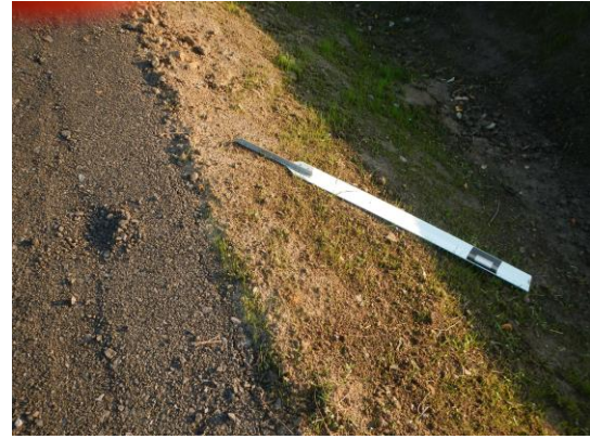
Obrázek 47: Neupevněný směrový sloupek
