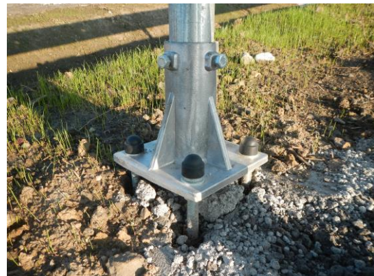
Obrázek 45: Neupevněné svislé dopravní značení
