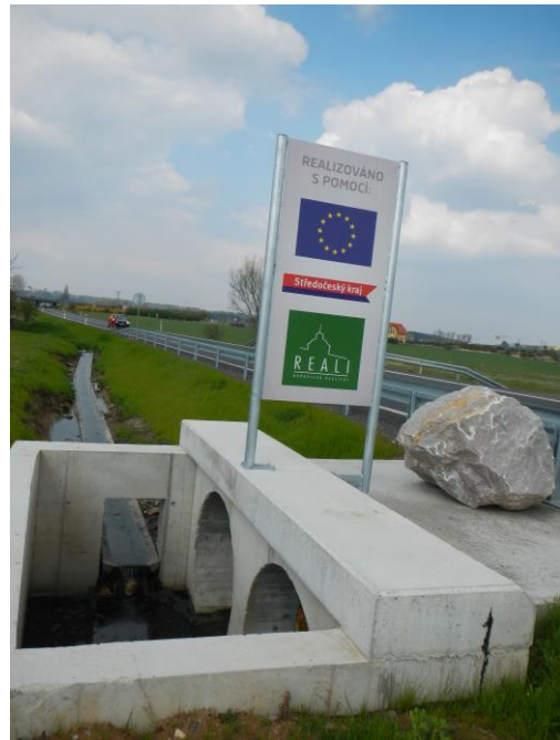
Obrázek 32: Betonová vtoková jímka
