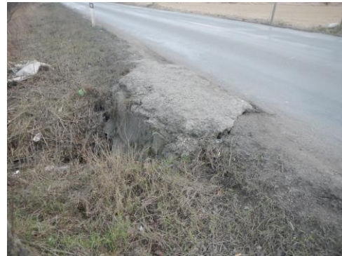
Obrázek 16: Zabetonovaná část komunikace
