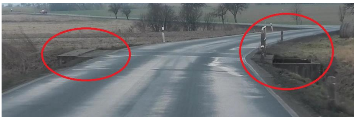
Obrázek 13: Umělé pevné překážky – vtoková jímka, zábradlí
