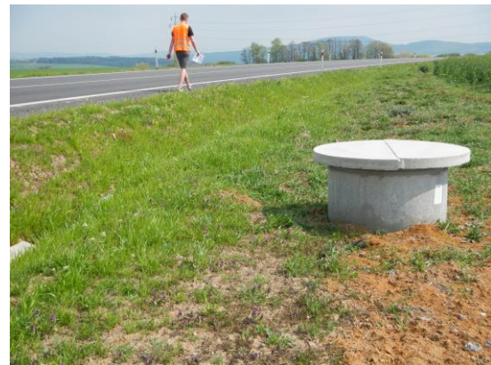
Obrázek 27: Umělá pevná překážka – betonová skruž
