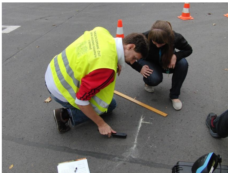
Obr. 17 – Odstranění nečistot z povrchu vozovky
