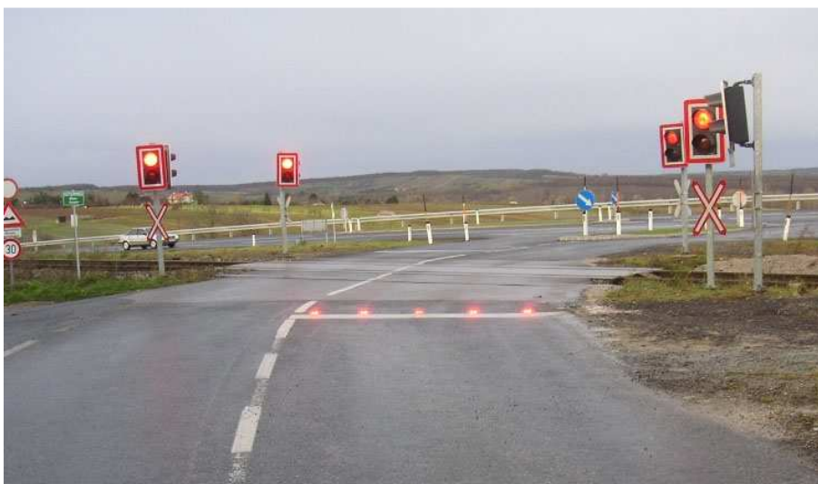
Obrázek 20 – Ukázka použití Lanelights na přejezdu v Rakousku [16]
