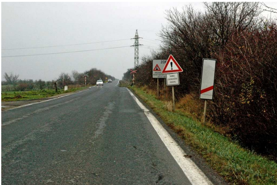
Obrázek 19 – Urychlující podélné line, nízký kontrast a zákryt dopravního značení na přejezdu č. P2106
