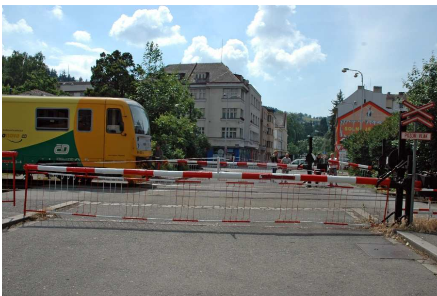
Obrázek 8 – PZM doplněný o závěsné sítě v na přejezdu č. P5098 v Náchodě
