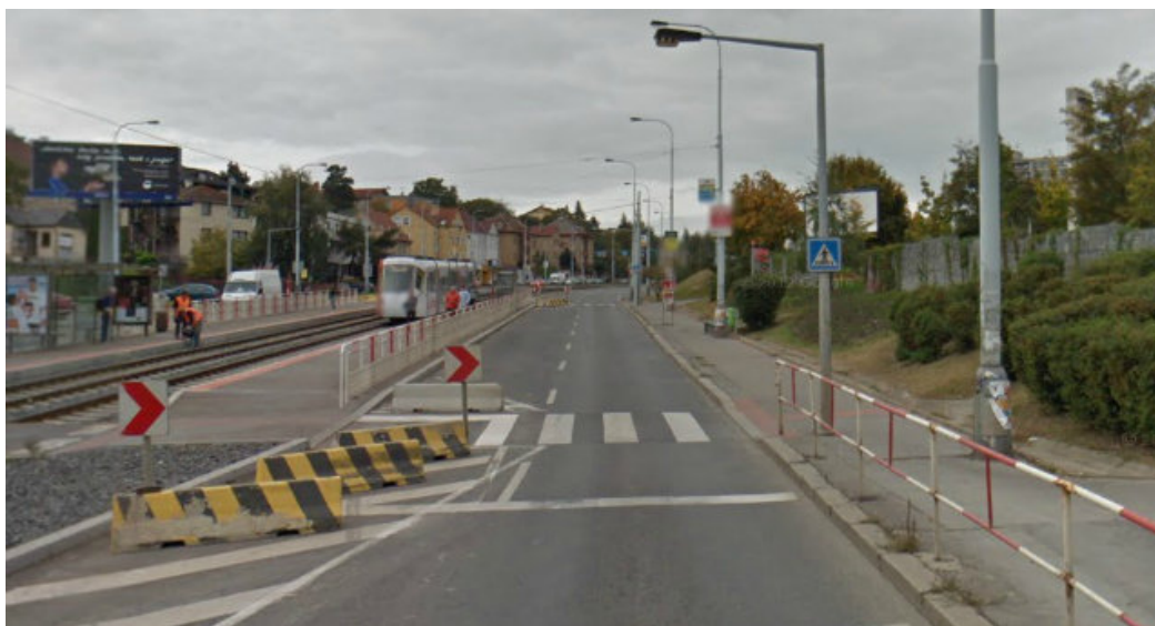
Obr. 39 - Přechod pro chodce u zastávky Hlušičkova z pohledu řidiče, zdroj [15]
