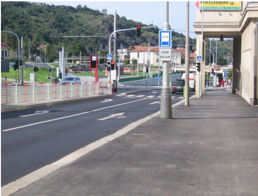
Obr. 3 - Pohled na zrekonstruovaný přechod pro chodce přes ulici Podbabská
