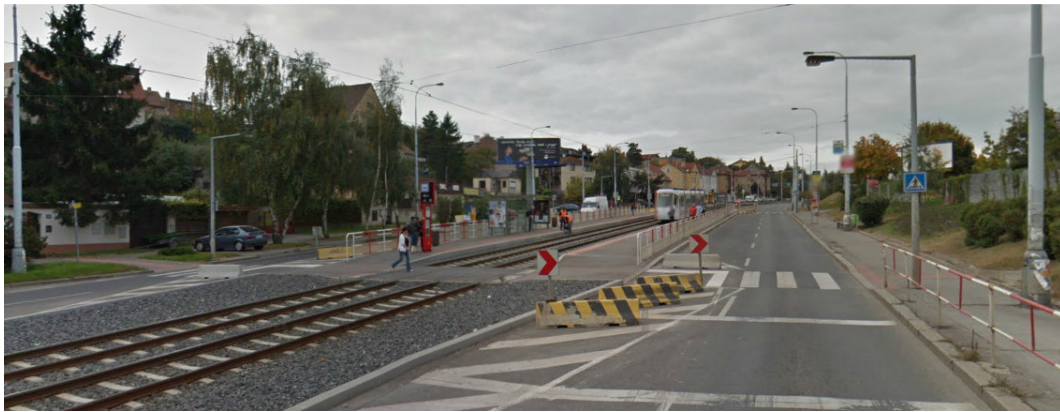
Obr. 15 - pohled na přechod pro chodce ve směru do centra, zdroj [15]
