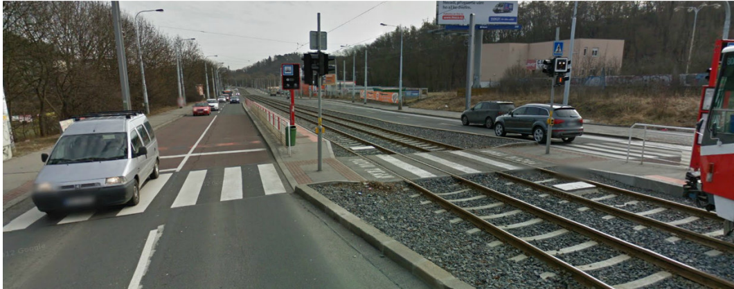
Obr. 12 - pohled na přechod pro chodce ve směru do centra, zdroj [15]
