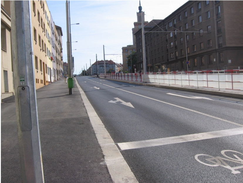
Obr. 6 - Rozhled na vozovku z pohledu chodce přecházejícího přechod pro chodce přes ulici Podbabská po rekonstrukci
