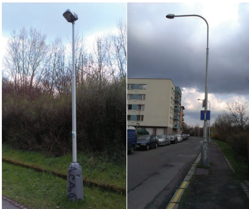
Obr. č. 41 – Vlevo svítidlo Sidonia Z1, vpravo svítidlo Safir 1
