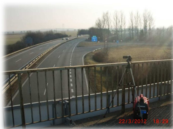
Obrázek 50 Pohled na analyzovanou lokalitu z pozorovacího stanoviště
