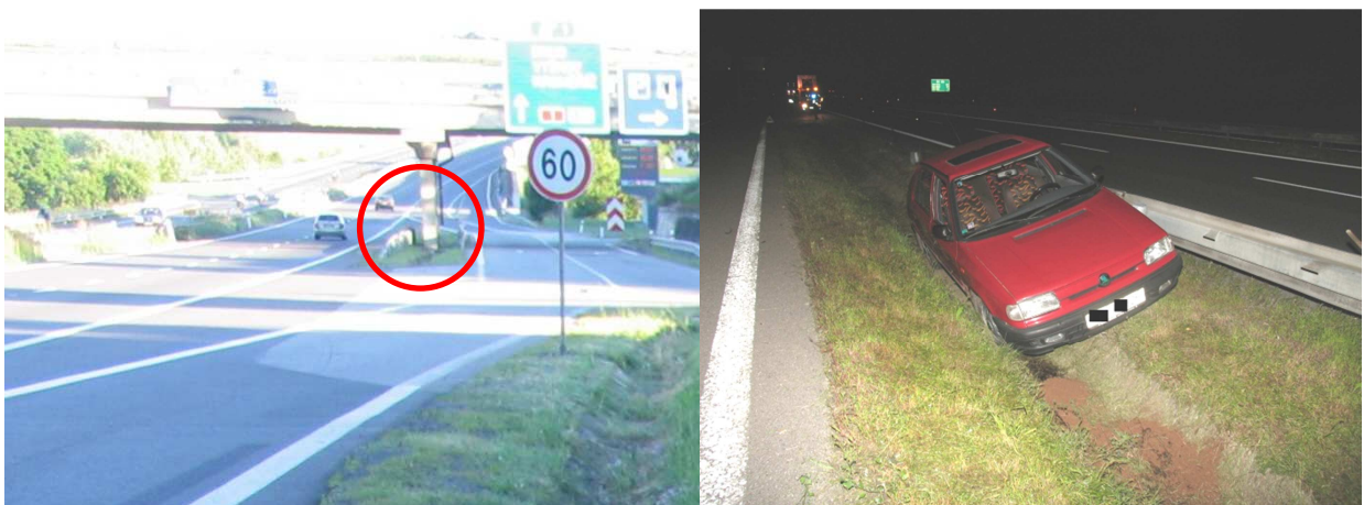
Obrázek 15 Nehodové místo 1 – chybí ochrana betonové konstrukce mostu
