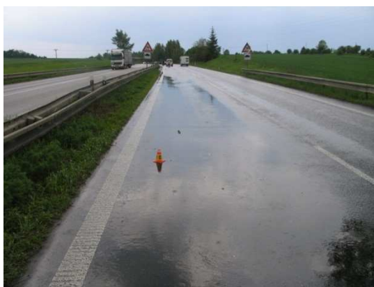
Obrázek 18 Nehodové místo 3 – detail stavu vozovky
