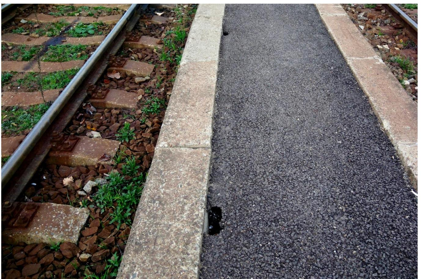
Obrázek 2.9 – Často přítomné díry u krajů asfaltového povrchu.
