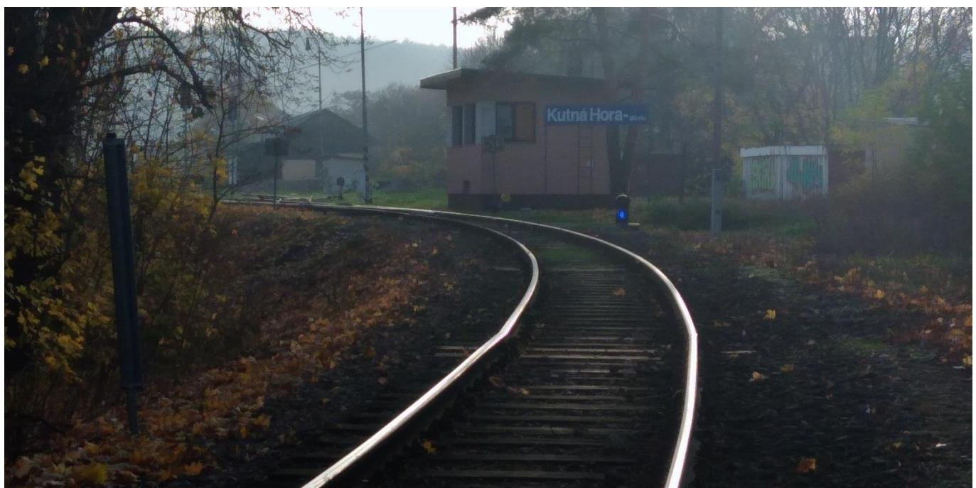
Obrázek 2.5 – Proti slunci zřetelně viditelný nevyhovující stav styku.
