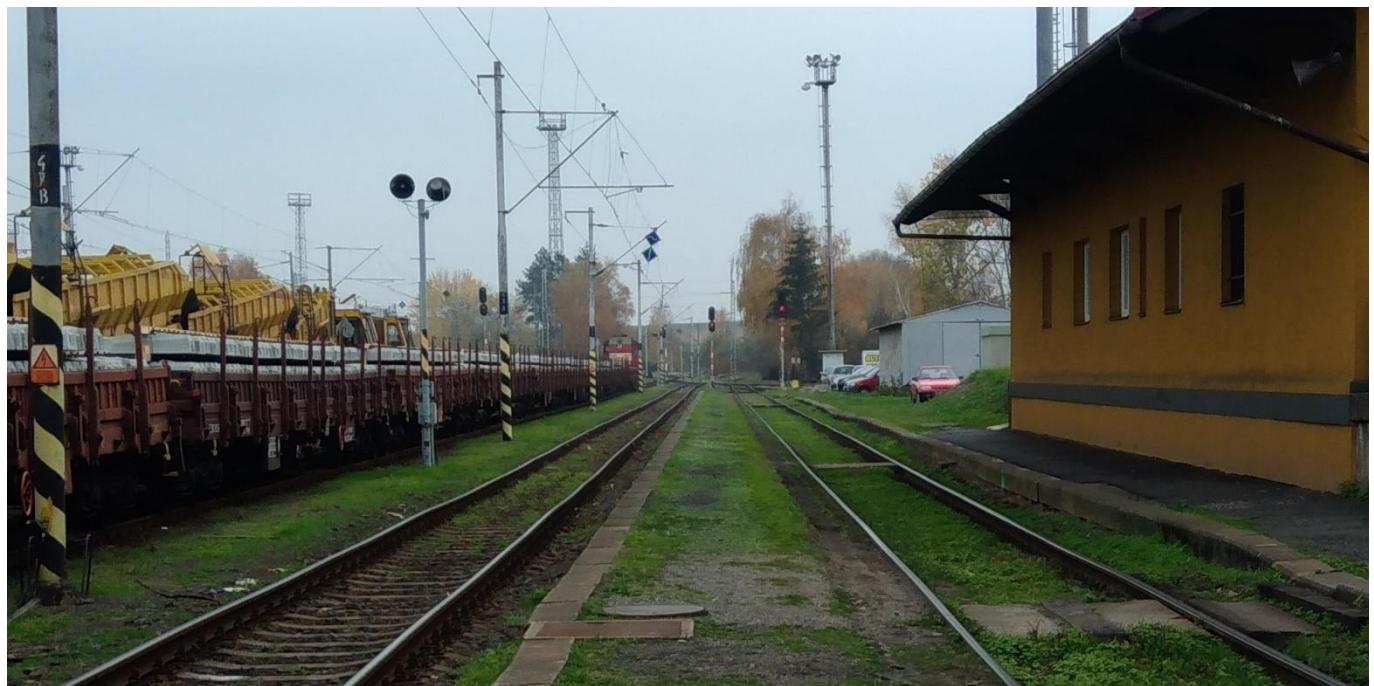
Obrázek 2.2 – Zvlněné kolejí jsou patrné na první pohled i z výšky očí.
