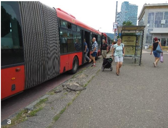
Obr. 25: Stav zelene (a – rozrušovanie nástupnej hrany, b – v električkovom obratisku) zdroj: autor
