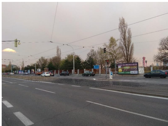
Obr. 16: Križovanie miestnej komunikácie s električkovou traťou. zdroj: autor
