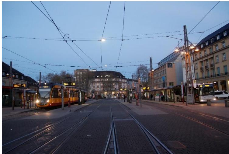
Obr. 58: Bezbariérové riešenie predstaničného priestoru Karlsruhe Hbf. zdroj: autor
