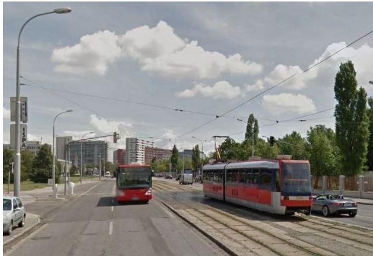
Obr. 30: Električková trať na zvýšenom páse z BKV panelov. zdroj: [25]
