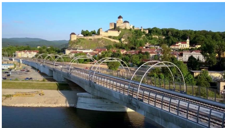
Obr. 5: Most cez Váh na hlavnom železničnom koridore v Trenčíne. zdroj: [18]
