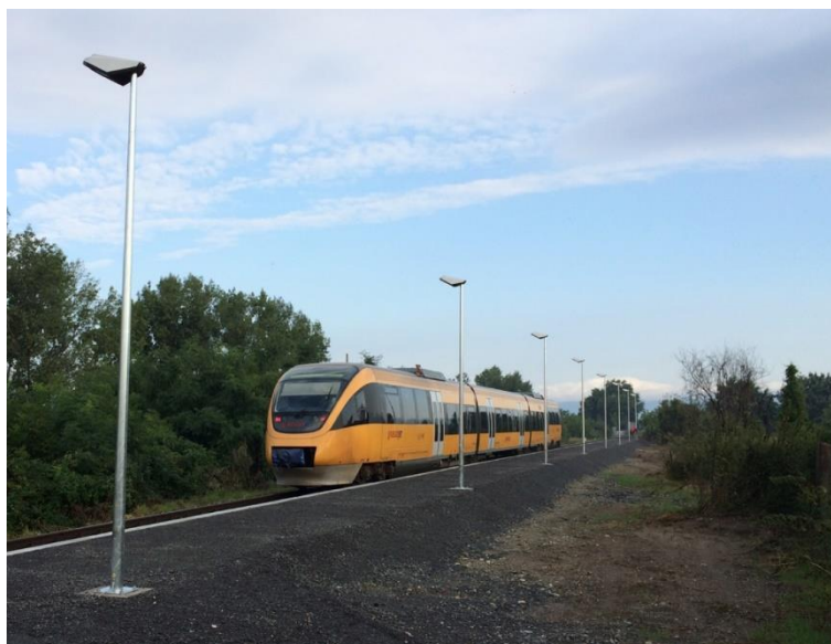
Obr. 50: Provizórna zastávka Bratislava-Vrakuňa. zdroj: [51]
