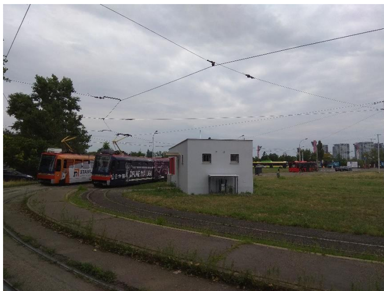
Obr. 33: Zázemie pre vodičov vo vnútri obratiska. zdroj: autor
