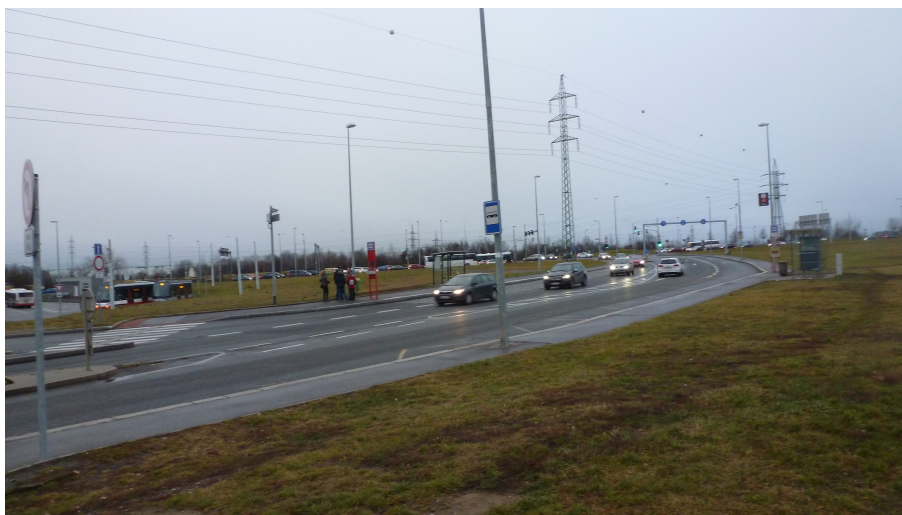
Obrázek 7: Pohled na dvojici zastávek Vypich v Ankerské ulici.
