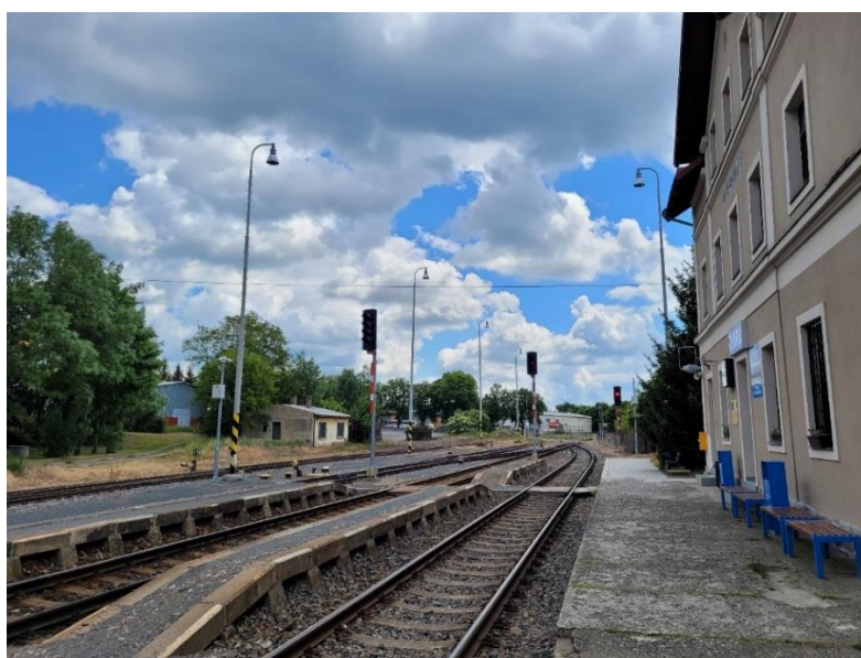
Obrázek 11: Kolejiště železniční stanice Dobříš (foto: autor)
