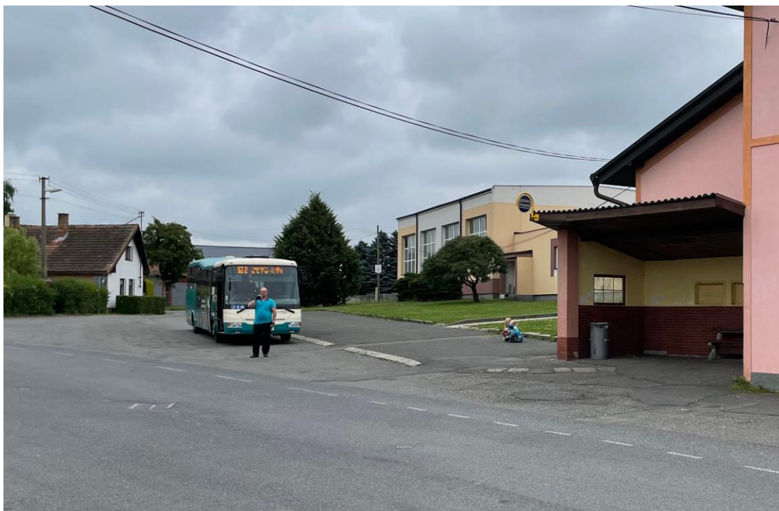
Obrázek 16: Nevhodné řešení autobusové zastávky ve Hvozďanech
