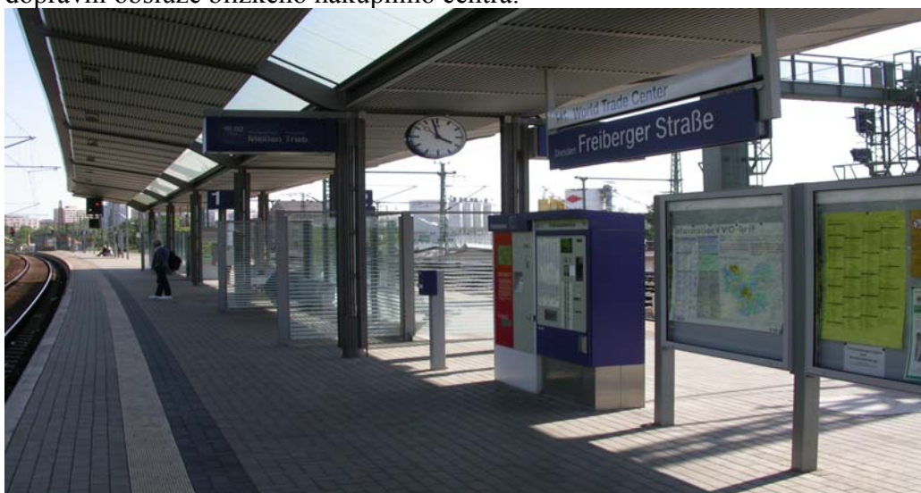
Obr.5: Zastávka Dresden Freiburger Strasse - příklad typické nově zbudované zastávky s ostrovním nástupištěm
