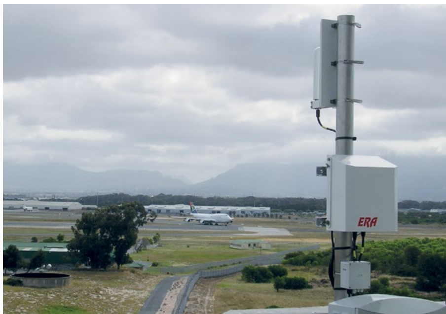
Obrázek 2.11: Profesionální přijímací stanice WAM systému společnosti ERA a.s., umístěná v Kapském Městě (převzato z [6]).
