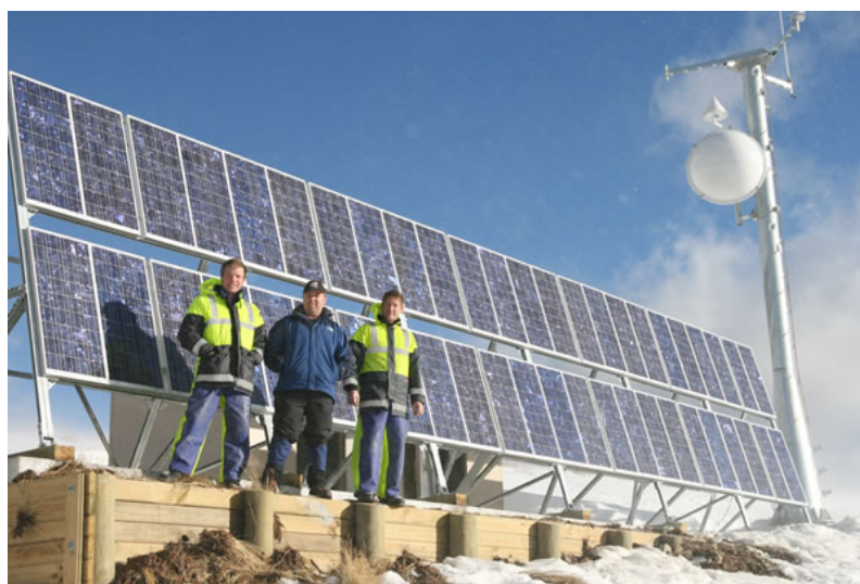
Obrázek 2.15: Příklad profesionální MLAT stanice od společnosti ERA a.s. na Novém Zélandu, napájené fotovoltaickými panely (převzato z [3]).
