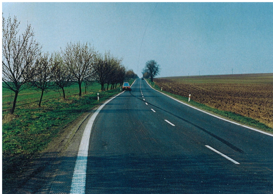
obr. 50 Stopa vyvráceného pravého předního kola, nezvladatelný výjezd doleva
