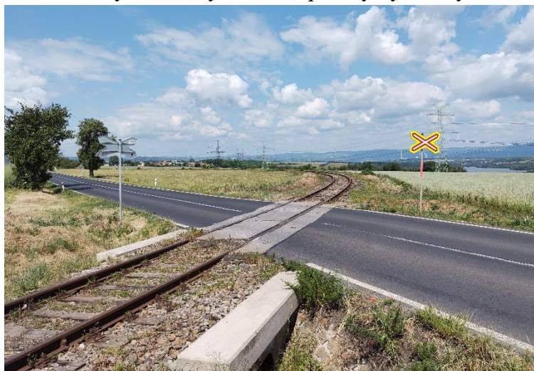
Obrázek 8 - celkový pohled na žel. přejezd P1892
